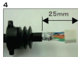
4 約25mmになるよう先端部分の余ったケーブルをニッパ等にて切断します。
