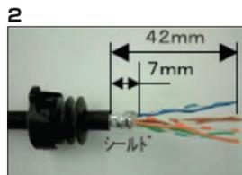
2 シースをストリッパで約42mmで剥きます。(シールド部約6~7mm)
