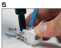
110工具(ハンチ工具)を利用してケーブルを奥まで「バチン」と音がするまで押し込みます。はみ出したケーブルは、ニッパ等でカットします。
