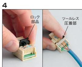
ロック用の部分で固定されている場合があるため、取り外します。ケーブルを先端まで可能な限り差し込みます。その後、ツールレス部分を押しつけて圧着します。組立完了です。
