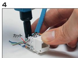
110工具(ハンチ工具)を利用してケーブルを奥まで「バチン」と音がするまで押し込みます。はみ出したケーブルは、ニッパ等でカットします。組立完了です。
