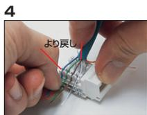
ケーブルをモジュラジャックの溝へ軽く押し込みます。
