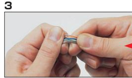
分解したケーブルをまっすぐにのばします。その後、シースムキの長さを14mmにカットします。
