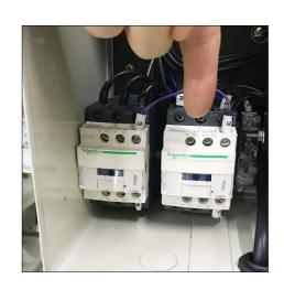
ヒーターリレーと同様に、リレーを上から押さえますと背面のレールのツメが縮み、取り外すことができます。
