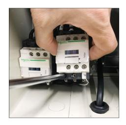
次に上側の配線も取り付けていきます。 配線を固定しているネジを増し締めし、線を引っ張って 問題なく取付されていることを確認してください。
