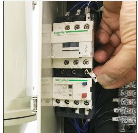
サーマルリレー上部の銅線を固定している3箇所のネジを緩めたところです。
