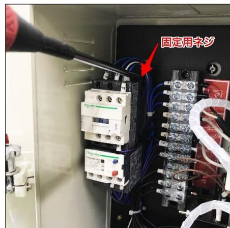
ブローリレーを外した後に上部の各配線を外します。
