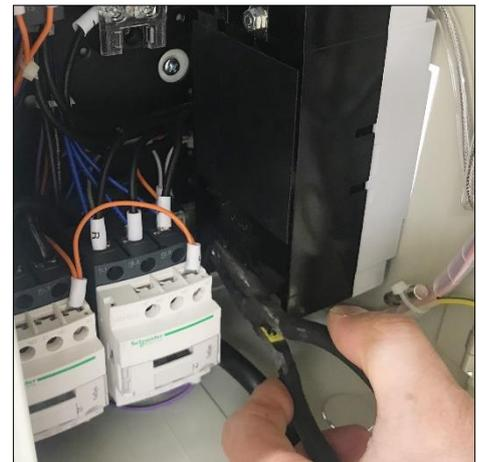
ブレーカーが右の写真のように外れますのでケーブルを外し交換します。
